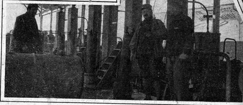
FIG. 3. — ATELIER DU MATÉRIEL CHIMIQUE A PONT-DE-CLAIX. — APPAREIL HACKSPILL POUR LA FABRICATION CONTINUE DU CHLORURE STANNIQUE.
